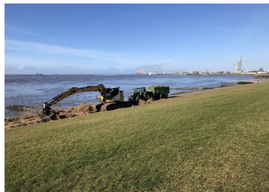
Treibselräumung auf dem Luneplatendeich
