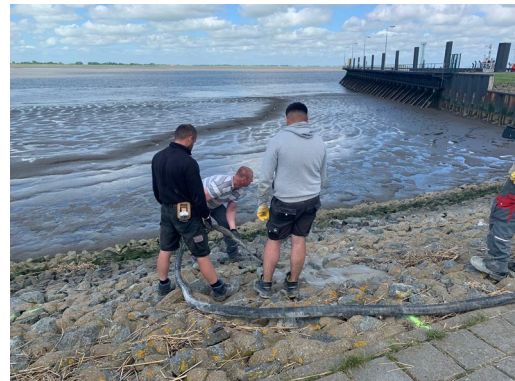
Verklammerung des Deckwerkes am Lohmandeich
