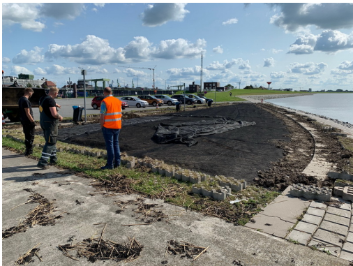
Verlegung eines Geogitters an der südlichen Geestemole
