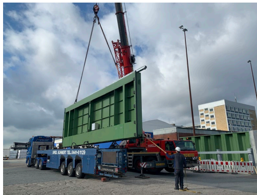
Deichtorarbeiten auf der Columbusinsel
