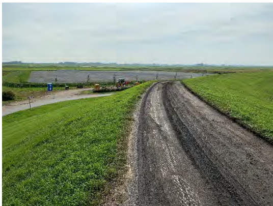
Erneuerung Deichrampe Luneplatendeich
