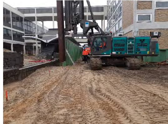
Bauarbeiten auf der Columbusinsel
