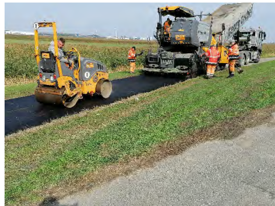
Asphaltierungsarbeiten Treibselräumweg
