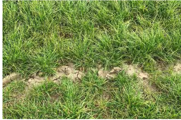
Bentonit-Pellets 2 Wochen nach Einbau
