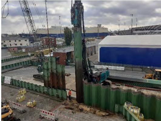
Bauarbeiten auf der Columbusinsel
