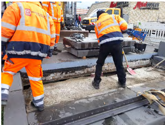
Sanierung der Treppe am Sail-City-Gebäude
