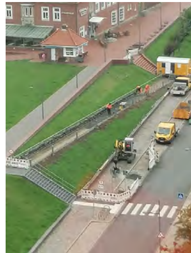
Sanierung der Deichrampe bei der Strandhalle
