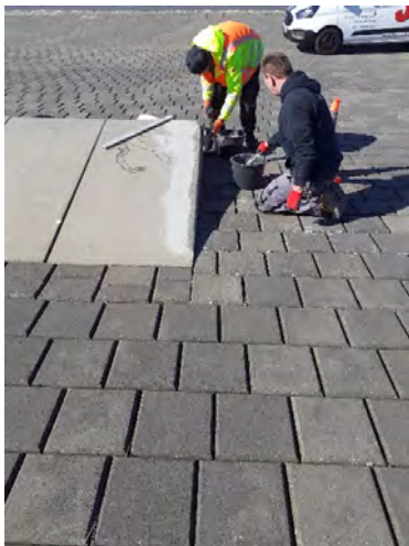
Betonsanierung Wellenbrecher
