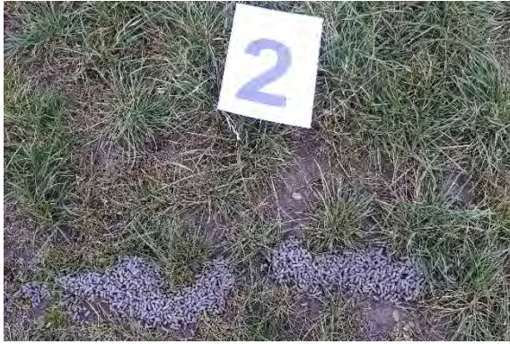
Bentonit-Pellets bei Einbau
