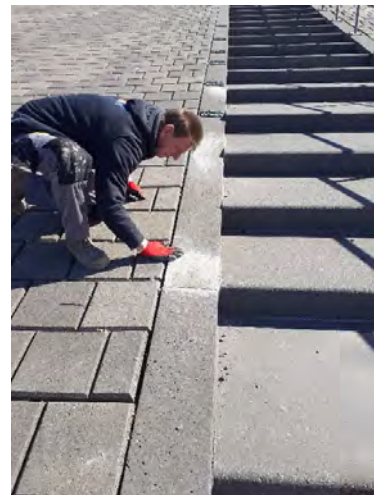
Betonsanierung Treppentwange
