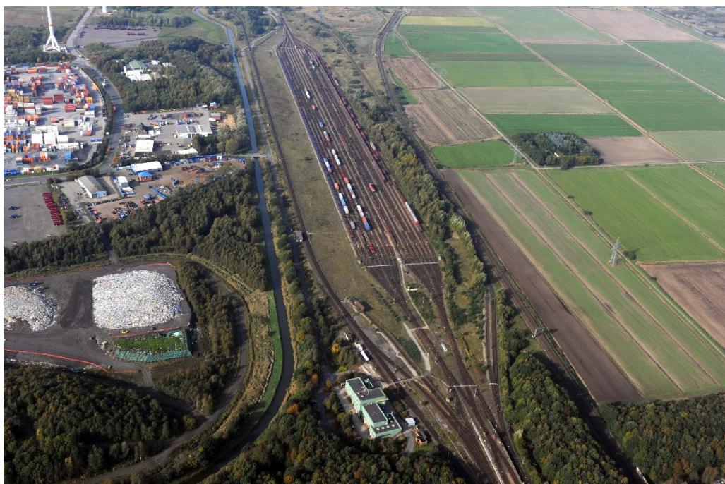
Abb. 9 Der (Rangier-)Bahnhof Bremerhaven–Speckenbüttel heute, Blickrichtung Nordwest, bremenports
