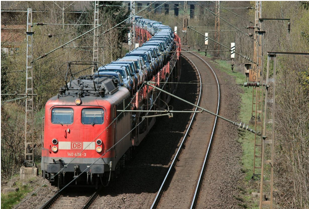
Abb. 27 E-Lok BR 140 mit Automobiltragwagen in Fahrtrichtung Süden an der Autobahnbrücke Bremerhaven-Wulsdorf, bremenports
