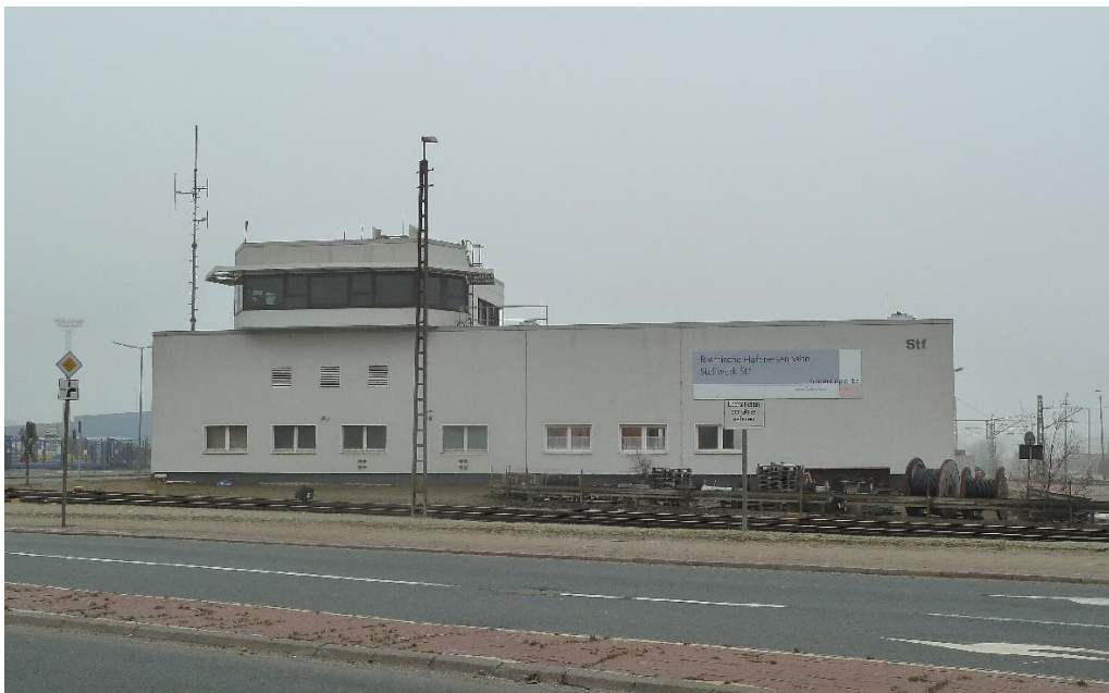
Abb. 16 Stellwerk Stromkaje Fahrdienstleiter (Stf), bremenports
