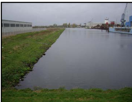
Abbildung 34 Plangebiet am Fuldahafen
