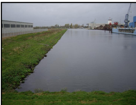
Abbildung 34 Plangebiet am Fuldahafen
